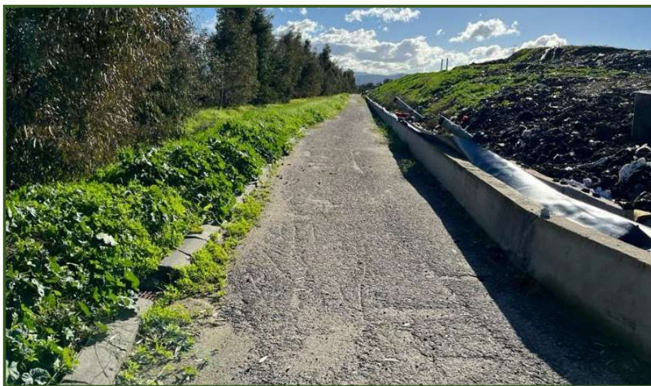
Figura 3.2/III: Raccolta acque lungo pista perimetrale lato est
