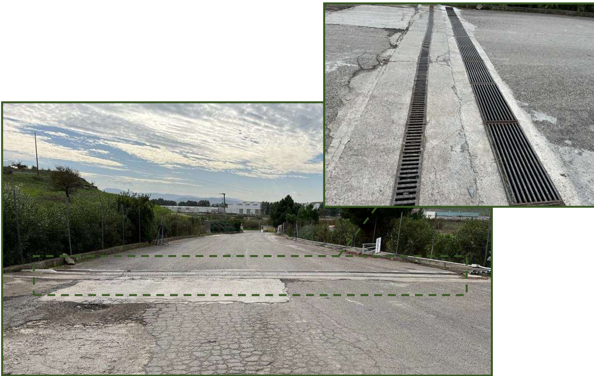
Figura 3.2/V: Grigliato raccolta acque prima pioggia aree pavimentate
