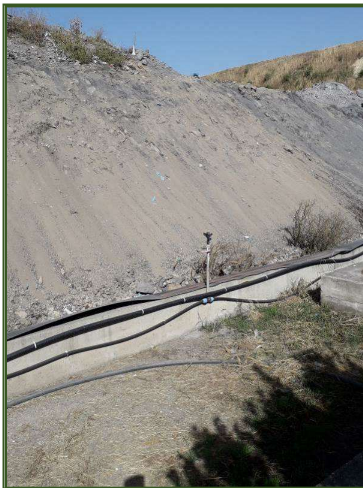
Figura 4.7/V: Impianto fisso di irrigazione del paramento delle scarpate
