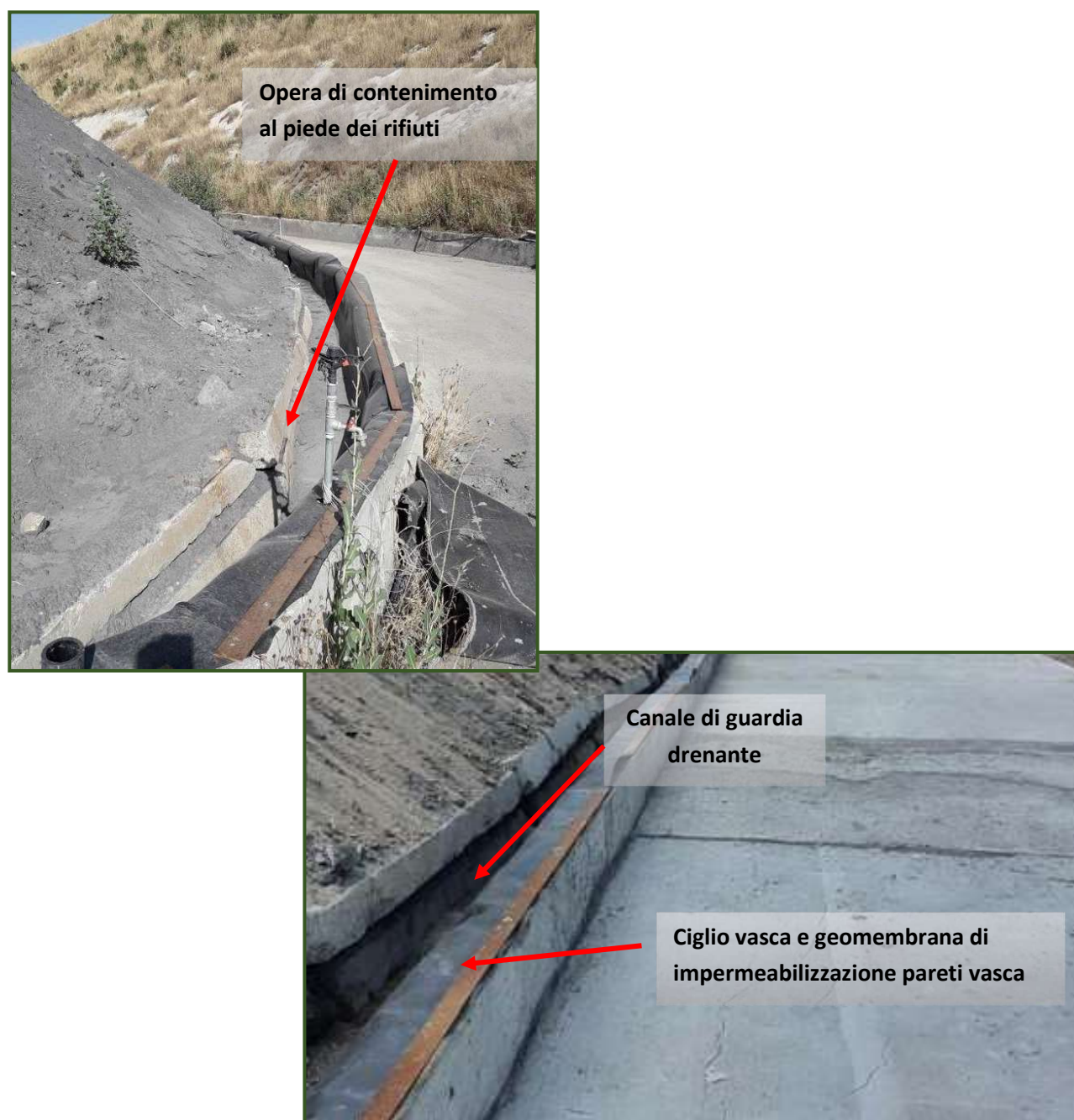
Figura 3.1/VII: Particolari opere di contenimento al piede
