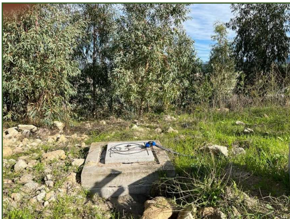
Figura 3.2/IV: Serbatoio di raccolta acque ricadenti su pista di servizio da immettere su sistema APP con sistema di pompaggi (vol. serbatoio 1000 l)
