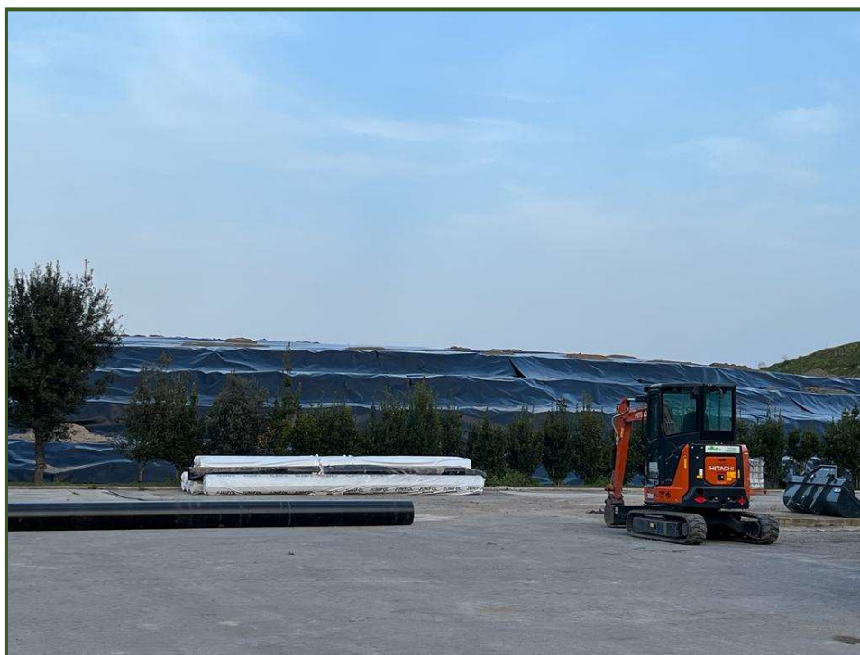
Figura 3.2/XXI: Chiusura provvisoria vasca V3
